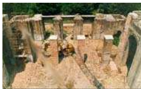
Изглед пре обнове изградње
